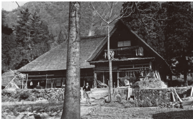
茅葺屋根の五十嵐家住宅（昭和26年5月頃）
