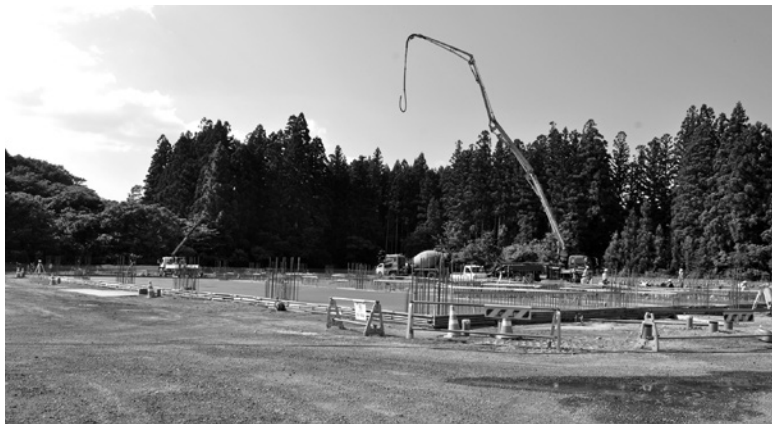
▲消防署建設地
