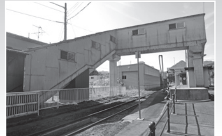
昇り降りの負担が大きい津川駅の跨線橋
