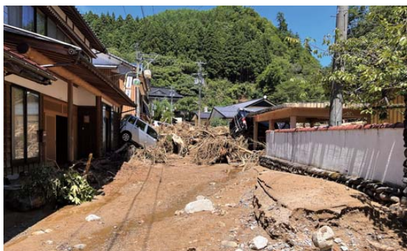
▲関川村の被災状況（一部）
