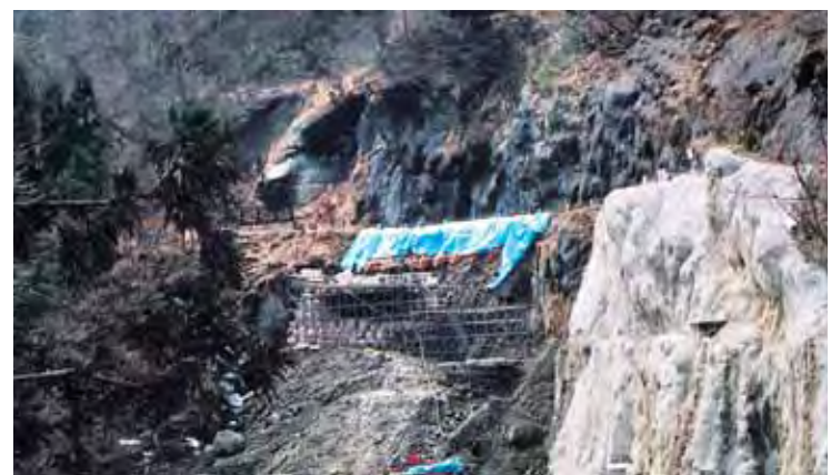
町道蟬ヶ平線改良工事（425百万円）
