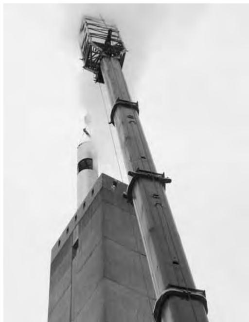
煙突内筒改修工事
