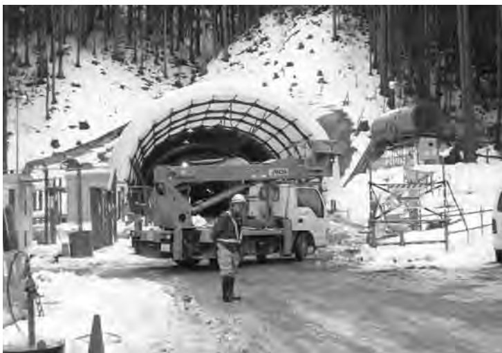
揚川バイパス三川口トンネル工事
