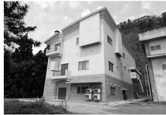
浄水場(津川地内)
