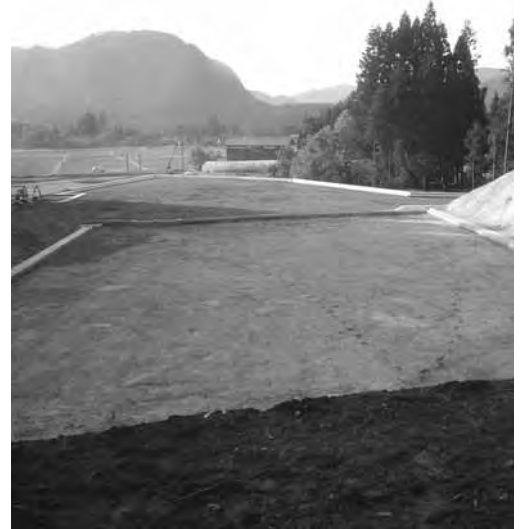
さい場建設地(鹿瀬地内)
