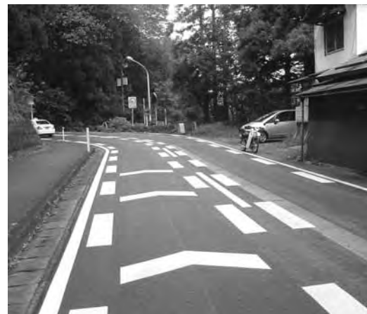
城山トンネル口付近
