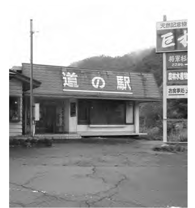
餅加工施設整備(岩谷全景)
