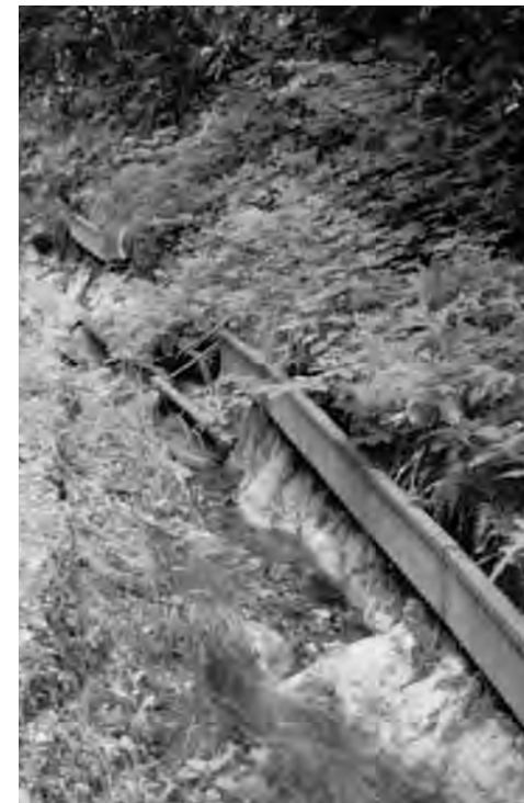
町道横沢線改良工事
