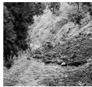
危ない!! 法面崩壊
