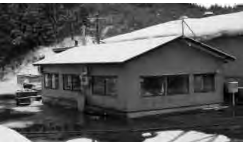
今年度中で使用中止の不燃物処理センター（長谷）
