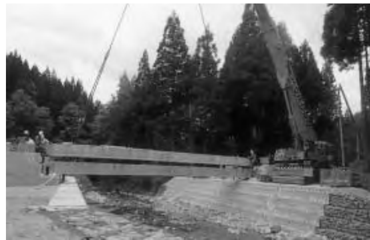
橋梁工事（町道細越行地線）
