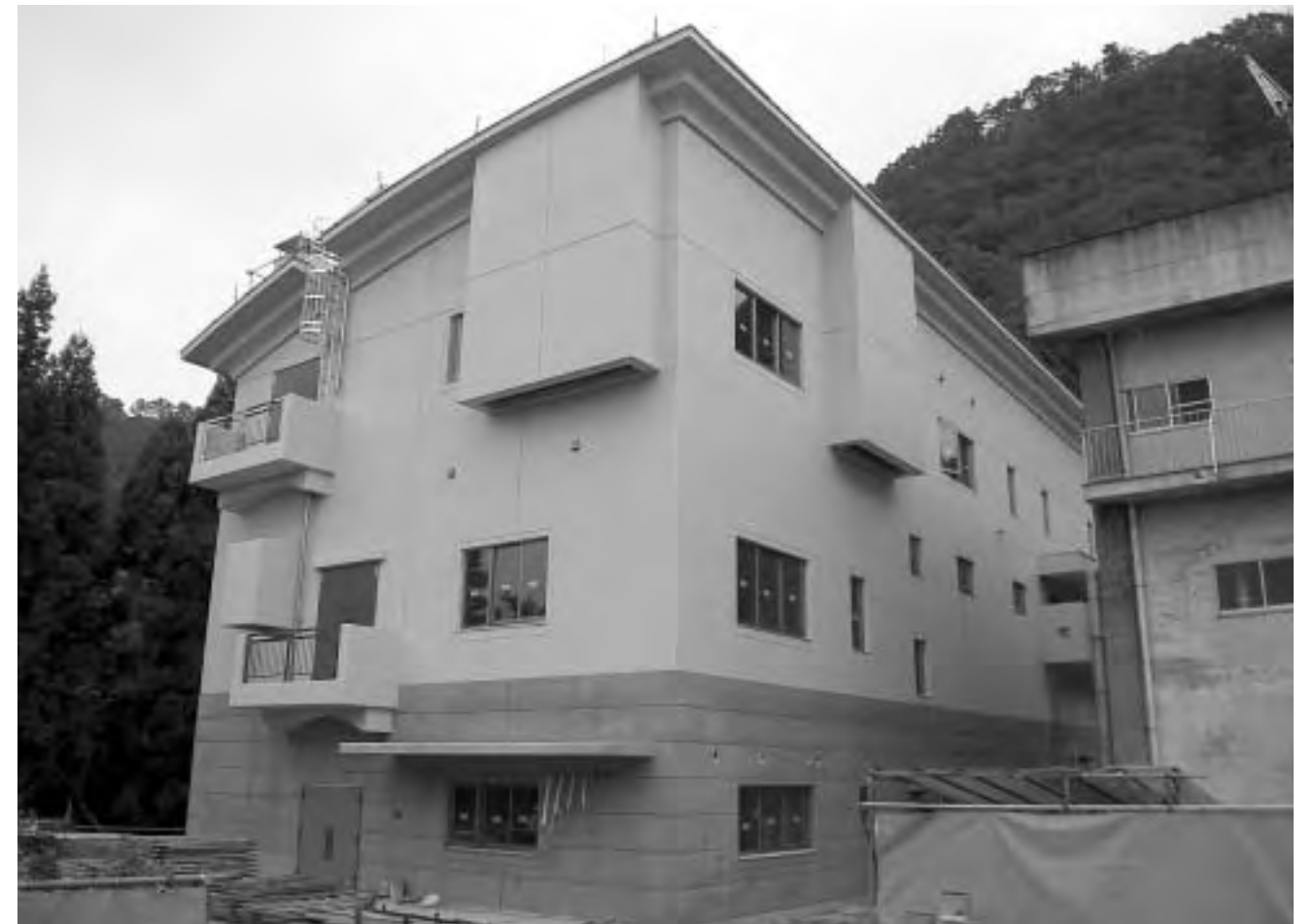
供用開始間近の上水道施設（津川上水道）
