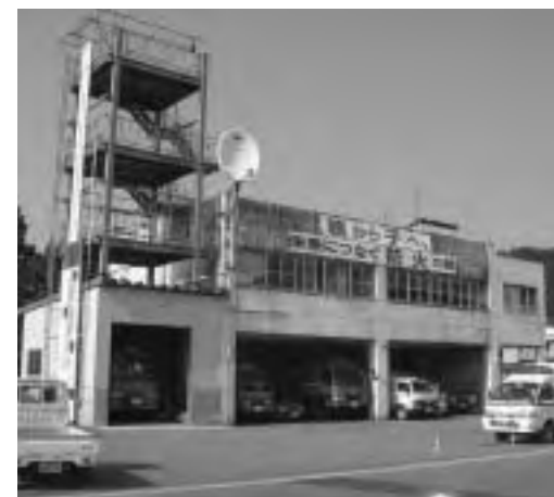
手狭なうえに老朽化がはげしい消防本部
