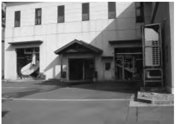
汚泥処理施設 (津川)
