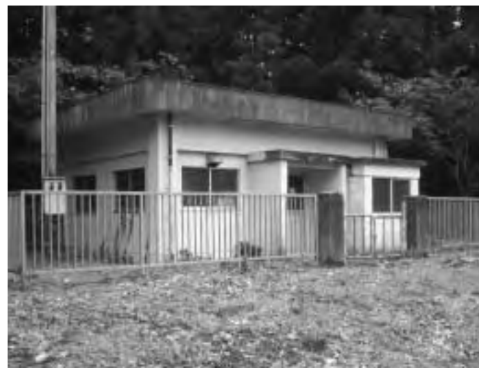
南部地区簡易水道施設
