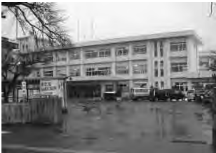
統合中学校予定地 (津川中学校)
