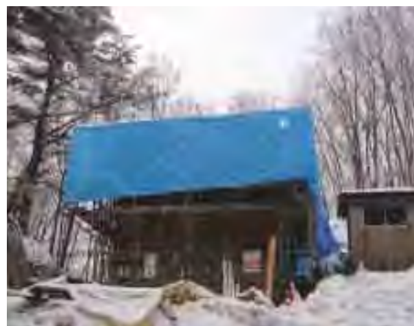
事件の元となった浄水施設
