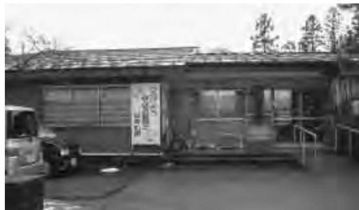
あがの作業所入口 (津川)
