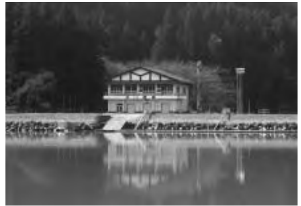
国体が開催されるために改修される艇庫
