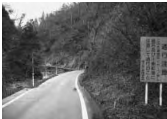
1キロメートル続く危険な県道 五十沢・中ノ沢線
