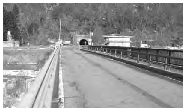
拡幅が望まれる城山トンネル
