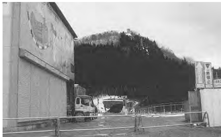
揚川バイパス・赤岩地区トンネル
