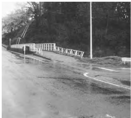
粟瀬川橋交差点
