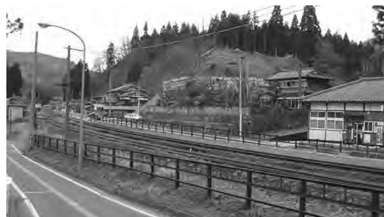
地すべり対策工事（五十島区）
