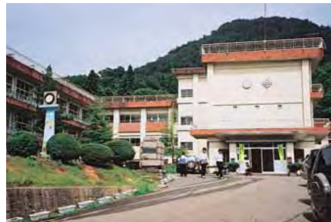
耐震、改修工事待たれる三川小中学校
