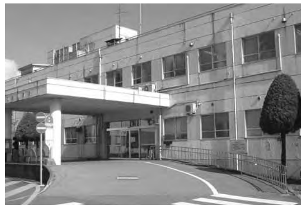
県立津川病院
