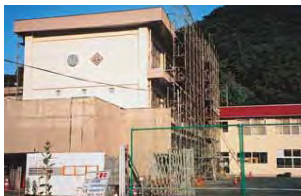
工事中の三川小中学校(工期11月28日)
