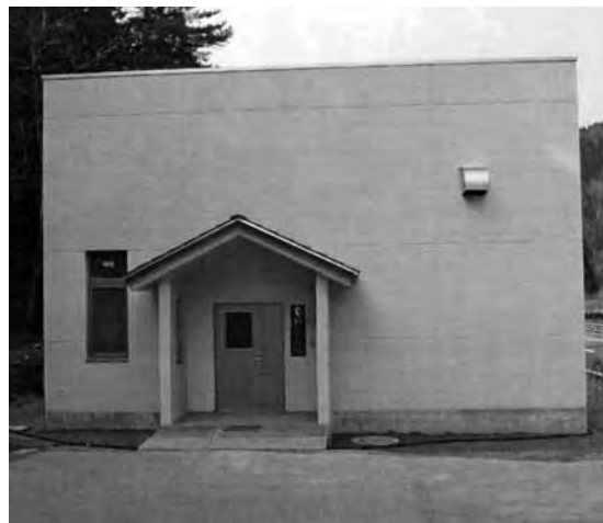
南部地区簡易水道施設(上川)
