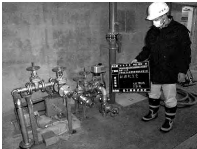
汚泥引抜ポンプ試運転確認
