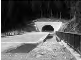
赤岩トンネル
