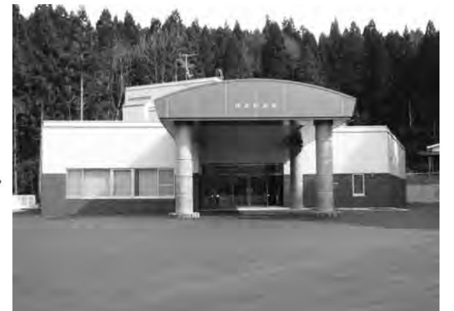
完成した新斎場
