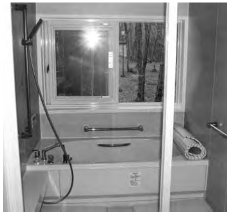
改修されたバンガロー(角神)
