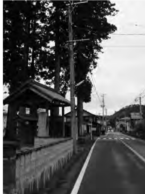
地域をてらす(防犯灯)
