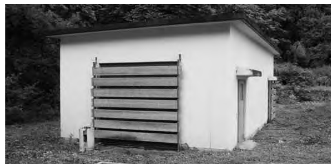
改良まれる粟瀬簡易水道施設
