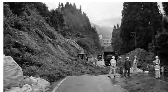
七名地区における土砂崩壊
