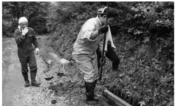
中山間直接支払い制度による共同作業(用水路改修)
