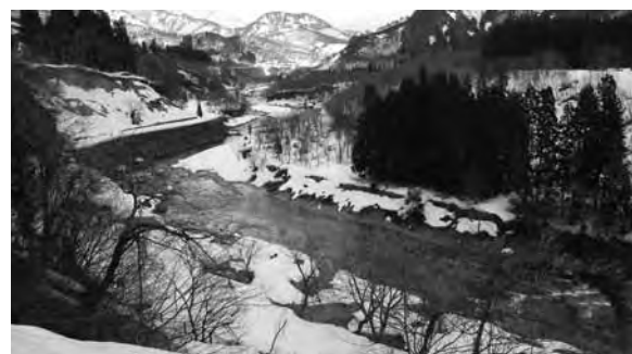
室谷より下流、貯水域を望む
