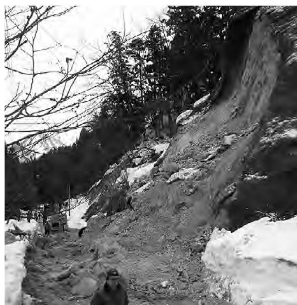
法面崩壊現場(深戸地内)
