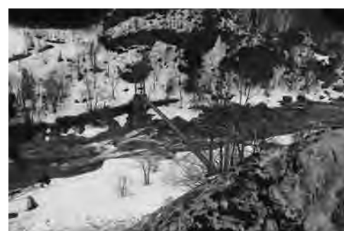
天の原吊り橋
