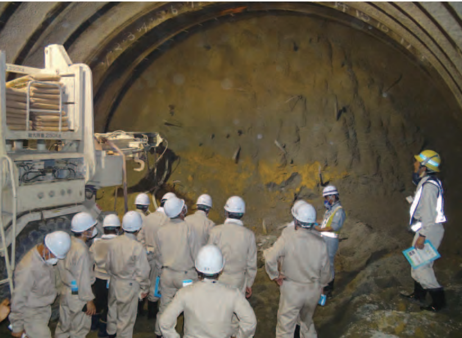
完成待たれる新津川トンネル
