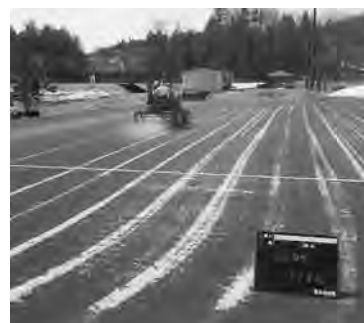
硅砂散布・充填状況
