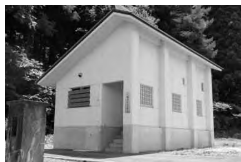
八ツ田浄水場
