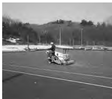
硅砂散布・充填状況
