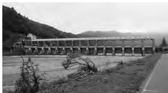
神だのみのダム(揚川)
