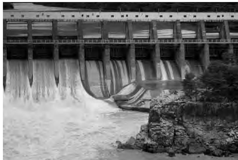
機能不全に陥った発電所(鹿瀬)
