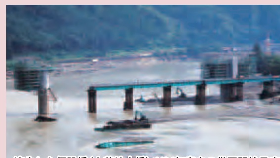
流失した仮設橋(小花地大橋):H24年度中の供要開始予定
