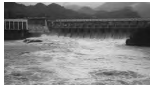
ダムゲート全開(鹿瀬ダム)
