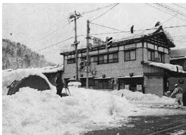
津川地区豪雪時雪下し作業
