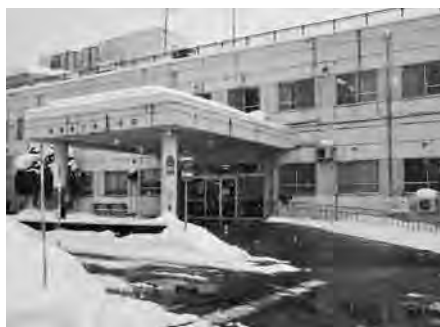
老朽化の進む県立津川病院
