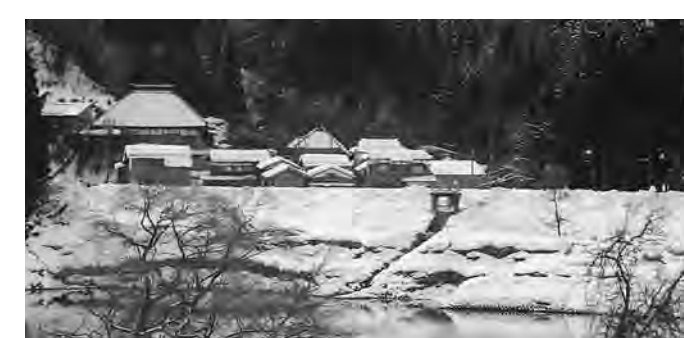
ポンプ設備の設置を(谷沢区)
