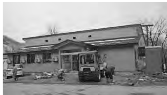
完成しつつある介護施設(角神)
