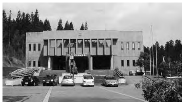
老朽化している文化福祉会館
