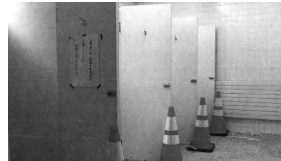
文化福祉会館トイレ改修
