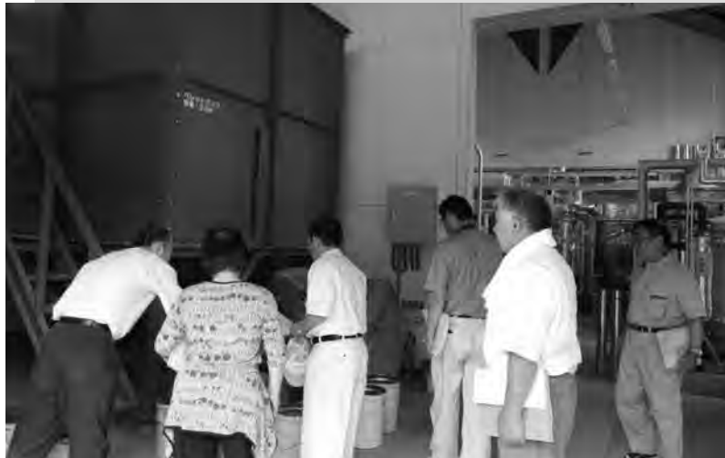
ペレットボイラー(清川高原)
