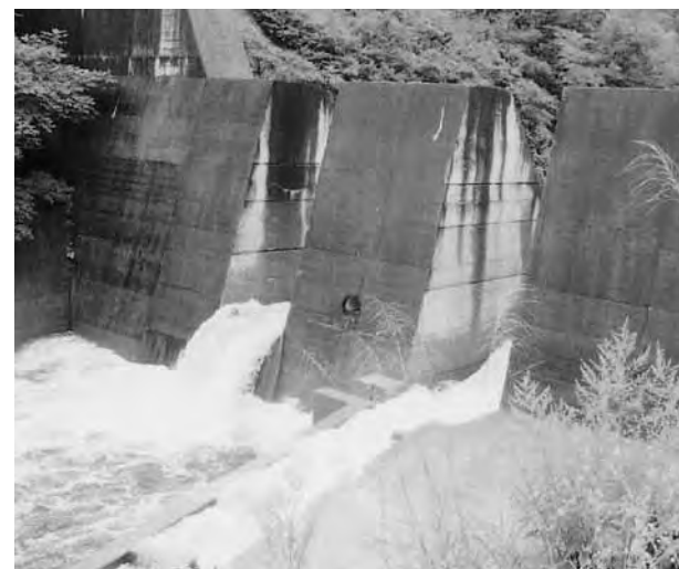
広谷川2号ダム・スリット
