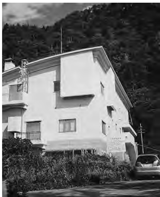
津川水道施設
