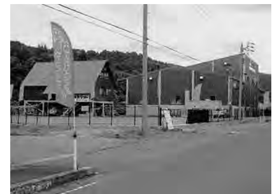
木質バイオマス施設(九島)
