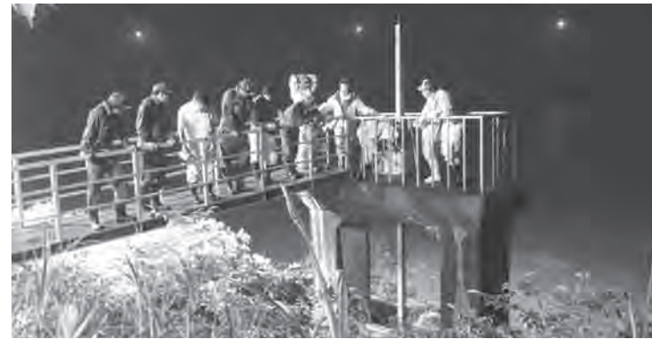
洪水時の排水作業（谷沢区）
