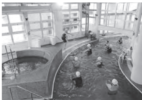
老朽化したプール
