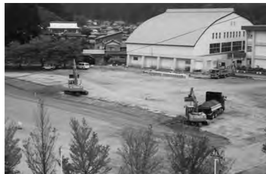
グラウンド改修中の津川小学校
