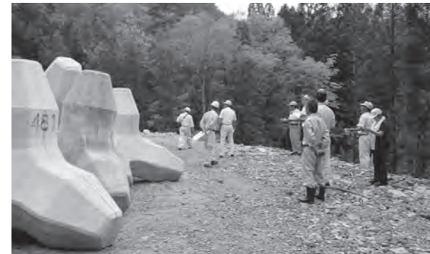
宮古沢上流域の崩壊現場(深戸地内)
