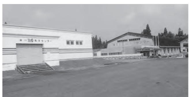
老朽化進む津川海洋スポーツセンター体育館
