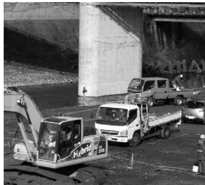
建設中の新寿橋
