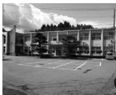
築61年の三川支所
