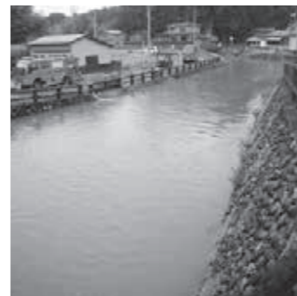
バックウォーターによる浸水被害
