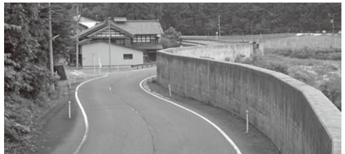
輪中堤で完成した川口地区
