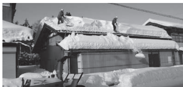
雪下ろし作業中
