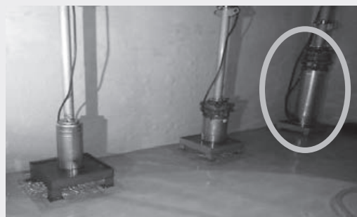
右側が故障した送水ポンプ（他2台は逆洗ポンプ）
