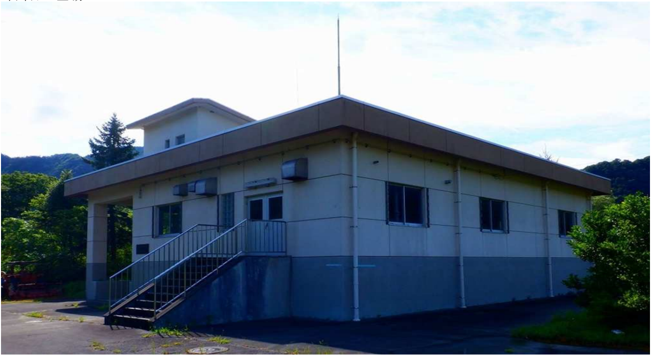
岩谷処理区No. 1 マンホールポンプ制御盤
