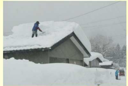
災害救助法適用による雪下ろし
