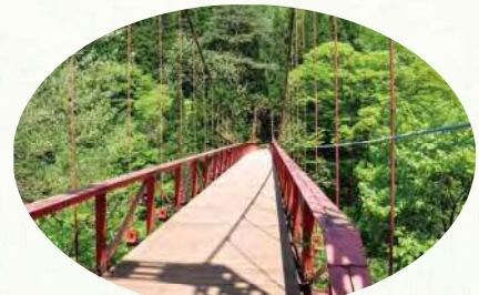
実川に架かる前川吊橋
