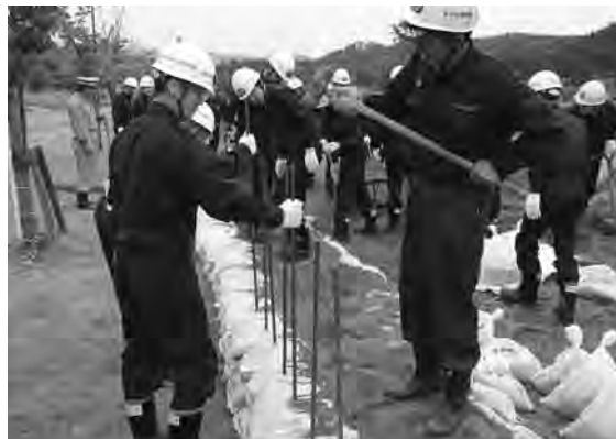
積み土のう工法に取り組む消防団員
