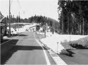
▲道路改良後の奥田区
