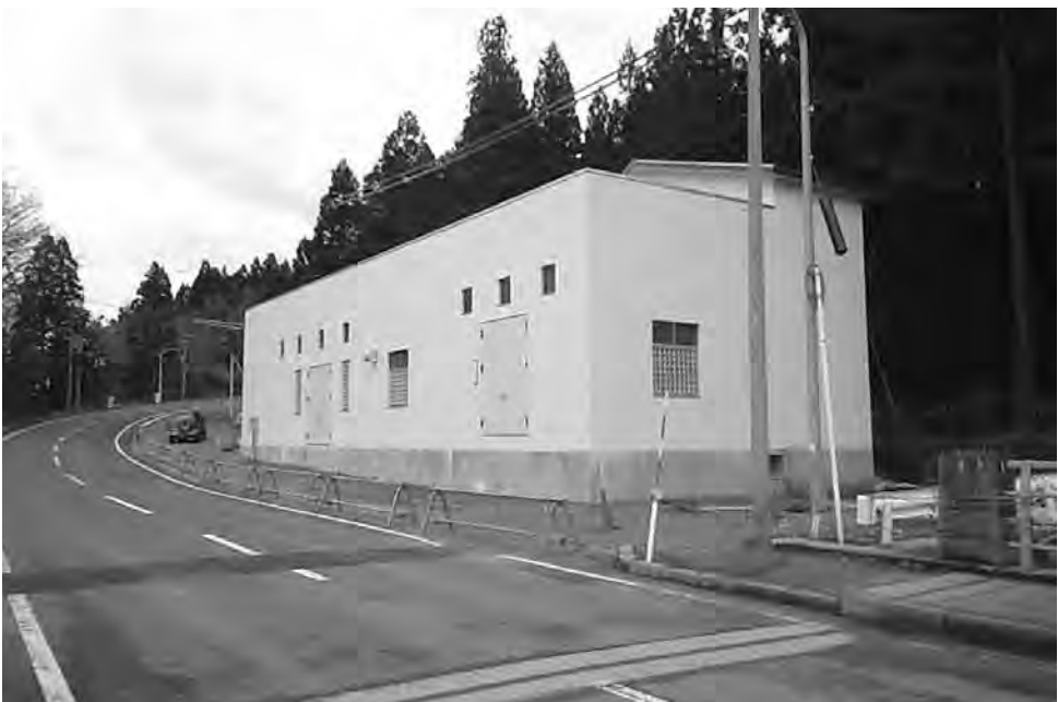
新設された中央南部簡易水道施設
