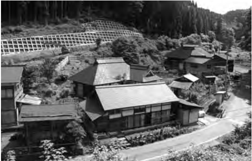
▲県道黒倉野中線改良工事中の面倉の様子
