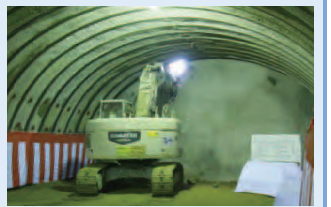
▲最後の壁を重機で掘削し、光が差し込む様子
