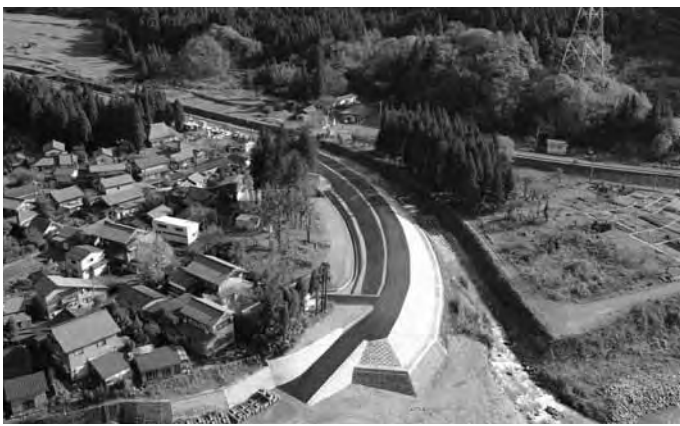
▲竣工した石戸集落を守る堤防
