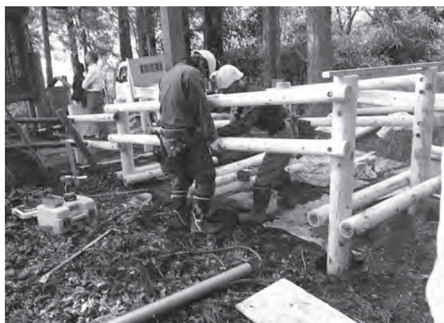
將軍スギ木道の架け替え工事
