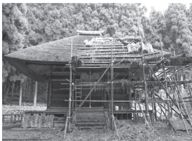
護徳寺観音堂の屋根修復作業
