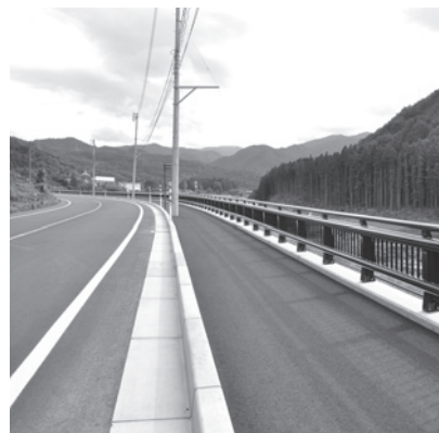
▲安全に通行できるようになった国道49号歩道（白崎～黒岩区間）
