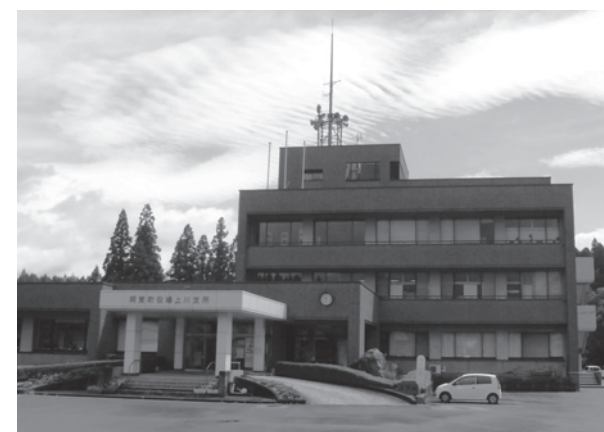
上川支所(正面)
