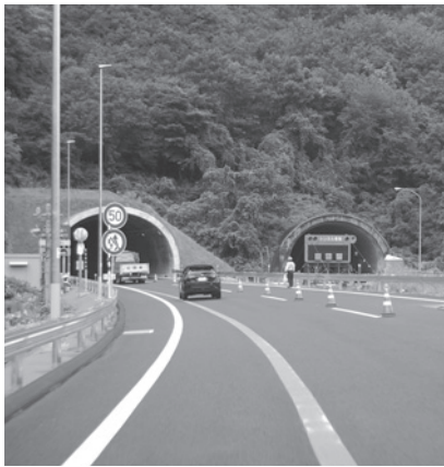
▲通行が可能となった新トンネル
