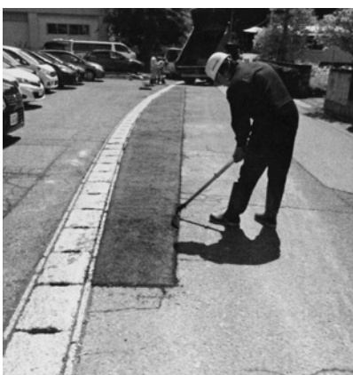
経年劣化による舗装の補修
