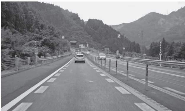
▲4車線化工事が進む磐越自動車道
