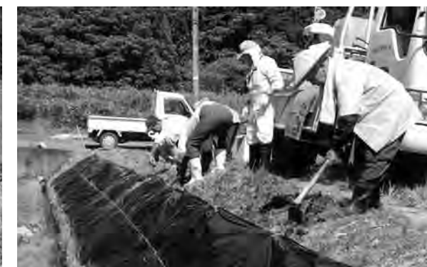
▲植栽作業の様子
