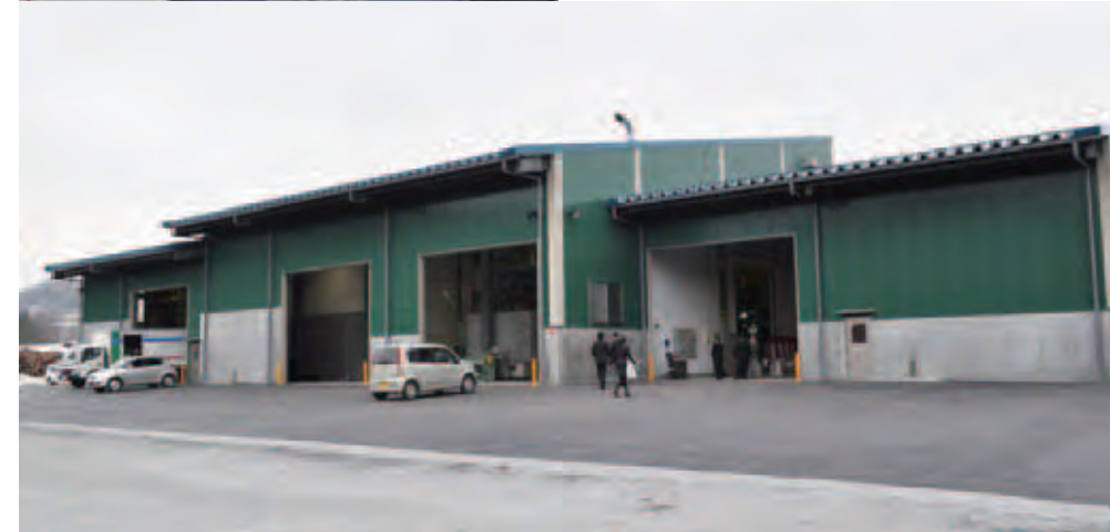
▲完成した木質バイオマス燃料等製造施設
