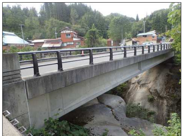
写真全景（コンクリート橋）
