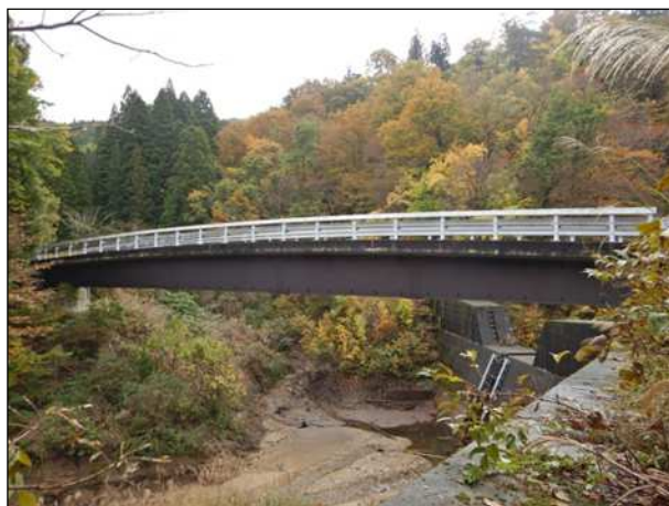
写真全景（鋼橋）
